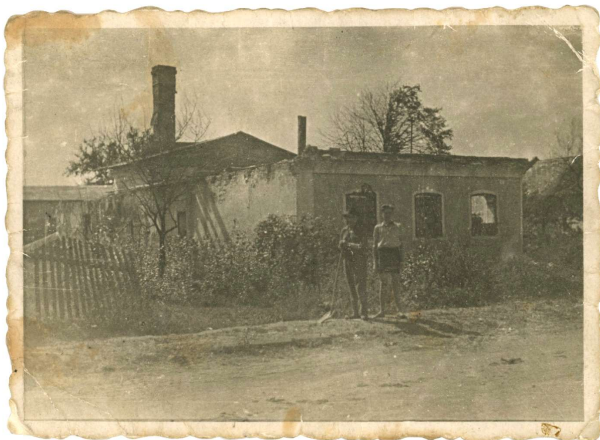
obr 39 - pohled na dům č.p. 17
