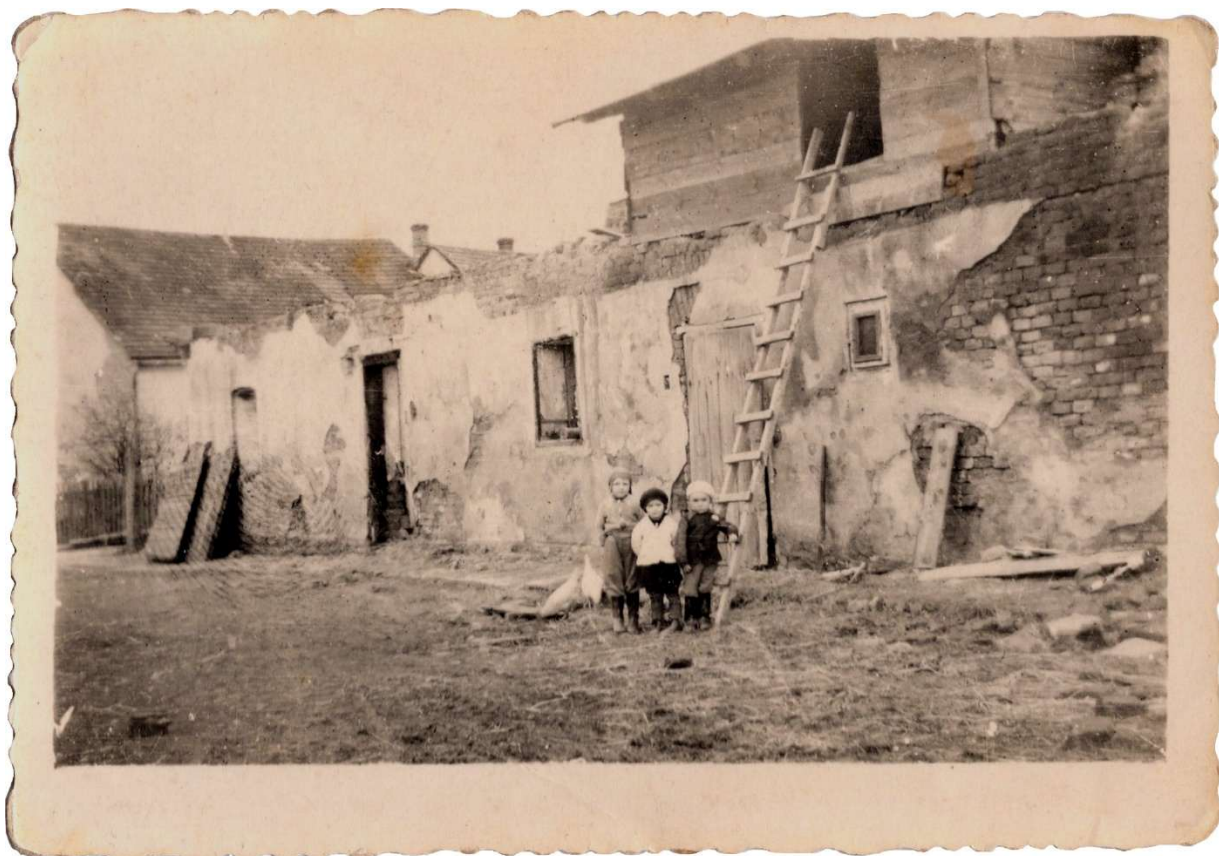
obr 40 - pohled na dům č.p. 17
