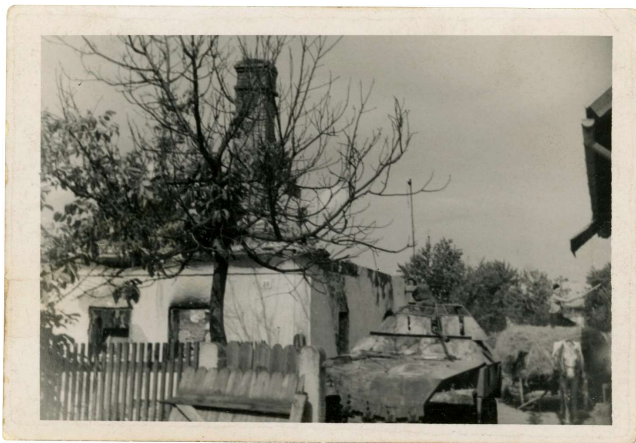
obr 20 - pohled do dvoru č.p. 39
