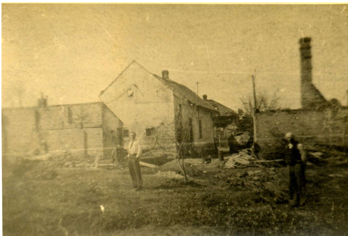
obr 26 - pohled od zahrady na č.p. 39 vpravo a č.p. 162 vlevo
