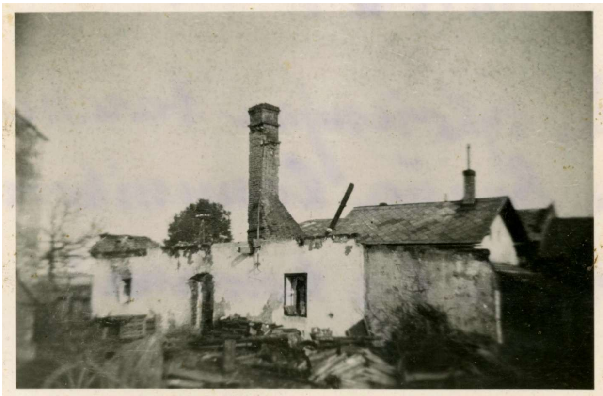
obr 28 - pohled ze dvoru na č.p. 39
