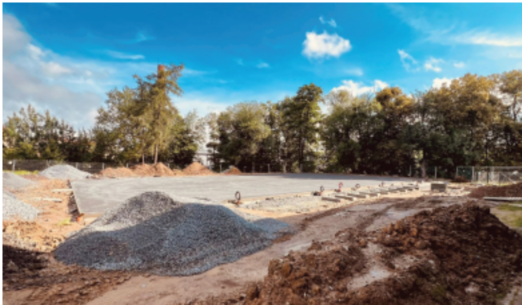
Výstavba víceúčelového školního hřiště je v plném proudu.
