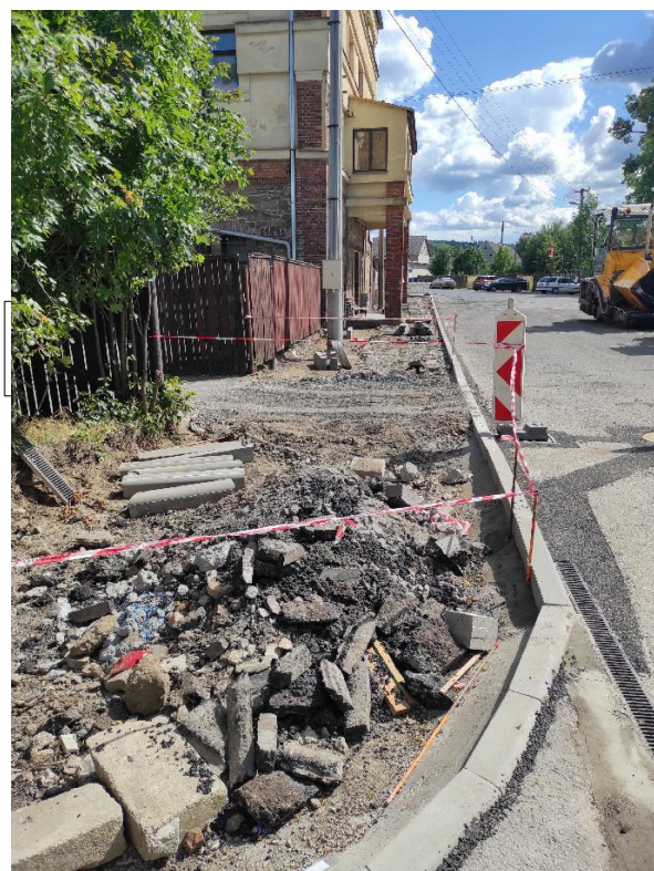
Byla zahájena rekonstrukce chodníku na ulici I. Kubince
