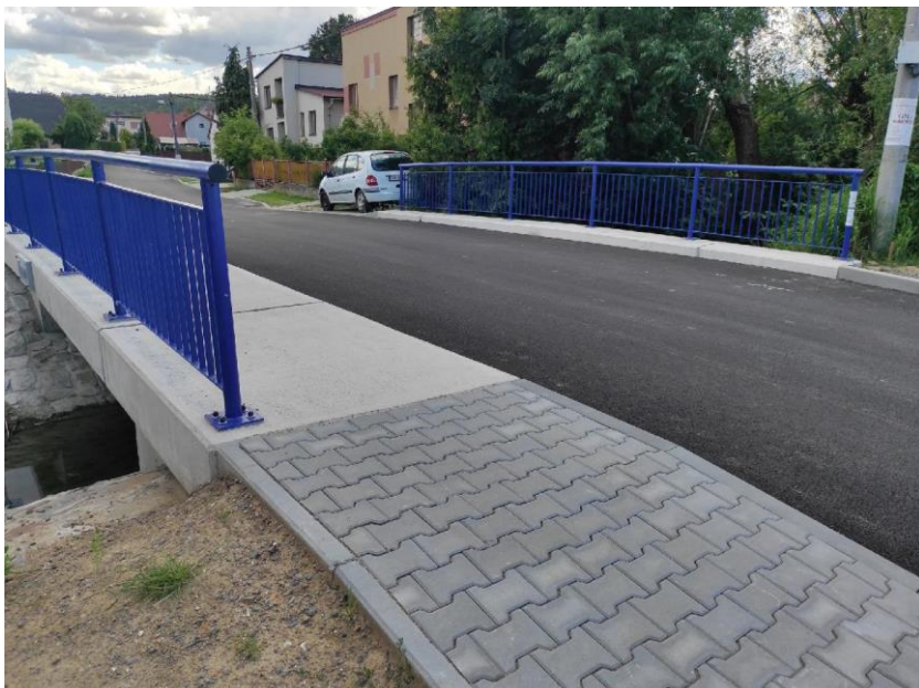
V měsíci červnu byla dokončena rekonstrukce mostu na ulici Havlíčkova
